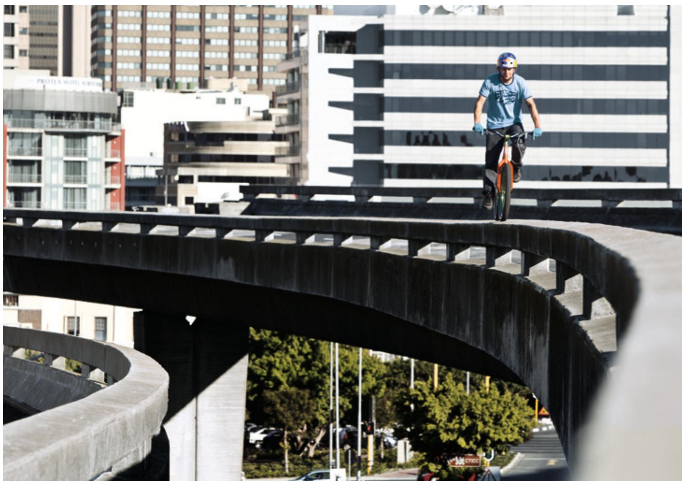
Le pont d'autoroute inachevé est une pure inspiration pour Danny. Néanmoins, avec 20 mètres de profondeur, le sportif de l'extrême vérifie lui-même avec soin la distance et la hauteur, l'adhérence et la qualité du béton.
